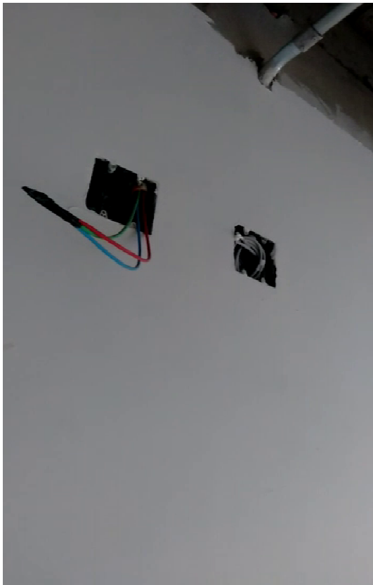
Fiação em espera para tomada
