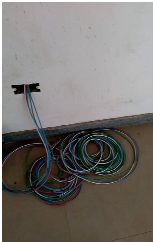
Fiação em espera para tomadas em canaleta na sala
